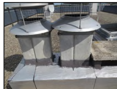
Photo N° 646 AMIANTE CIMENT -- Toiture terrasse Toiture Ventilation haute (Fibres-ciment)
